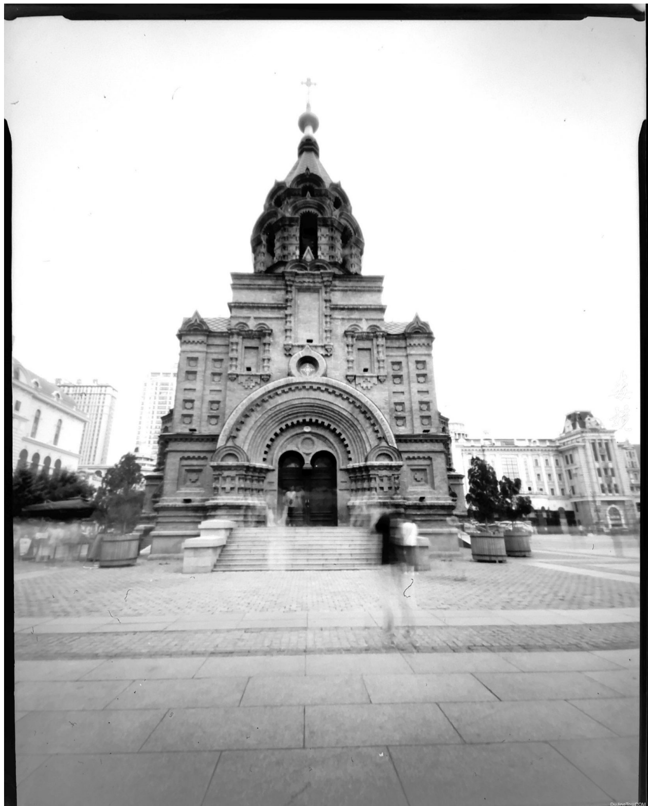
使用45大画幅拍摄的索菲亚大教堂。作者 阎七供
